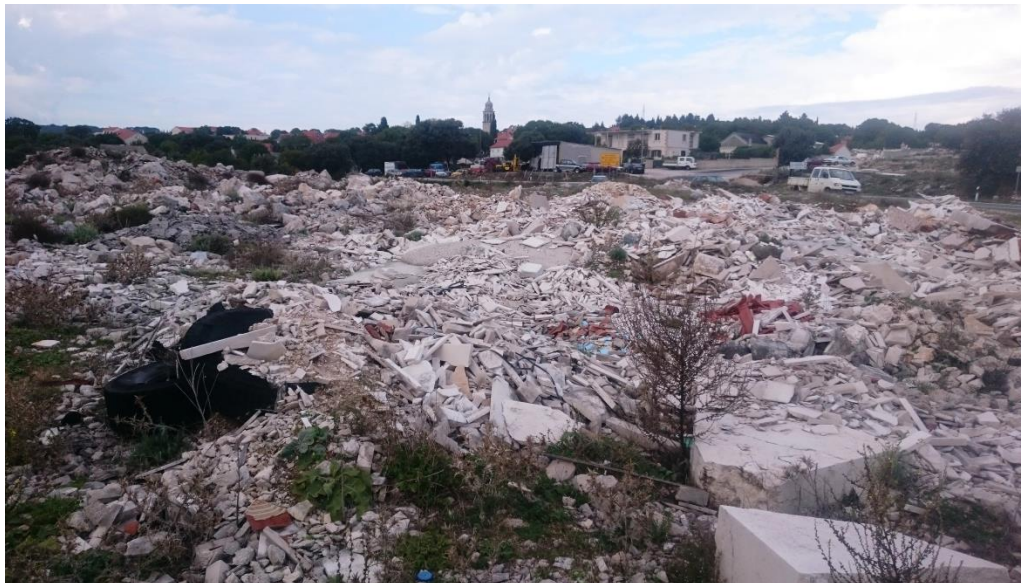
Slika 7. Napuštena baza tvrtke Viadukt pokraj naselja Pražnica, 2015. godina
